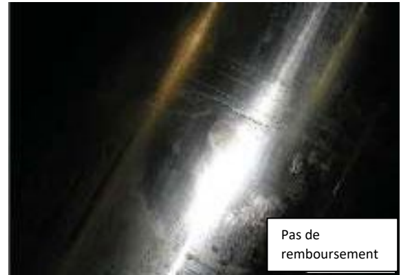
Figure 2 - Tige visiblement fissurée.
